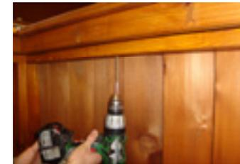
déposer le comptoir sur les murs du bar et vissé les bouts avec 4 x (A)
